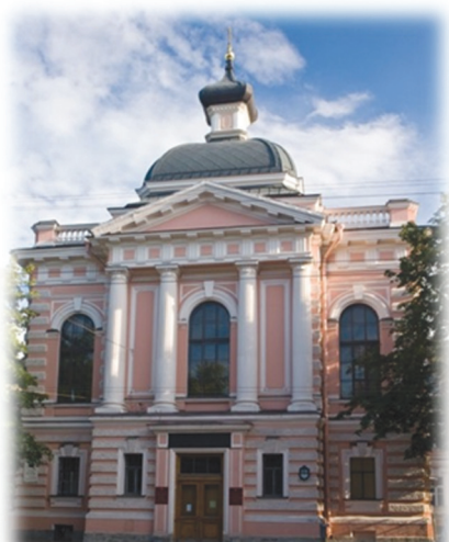
Рис. 8. Главный корпус Ленинградского государственного института для усовершенствования врачей
