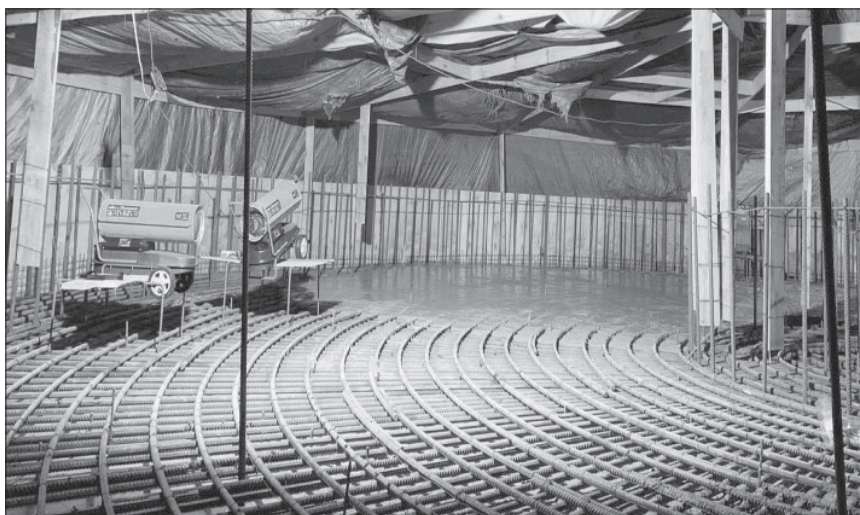
Рис. 1. Бетонирование густоармированной конструкции с использованием самоуплотняющейся смеси для жаростойкого бетона BRP B30 I11 F 1 150 W8 T 1 40, ГОСТ 20910–2019, полученной из сухой смеси
