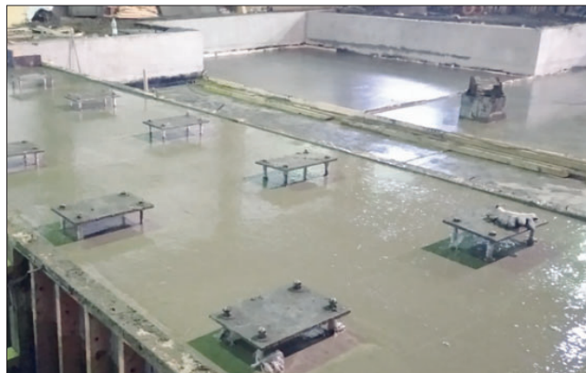
Рис. 3. Фрагмент готовой монолитной железобетонной конструкции под монтаж надфундаментных конструкций и оборудования Fig. 3. A fragment of a finished monolithic reinforced concrete structure for the installation of above-foundation structures and equipment
