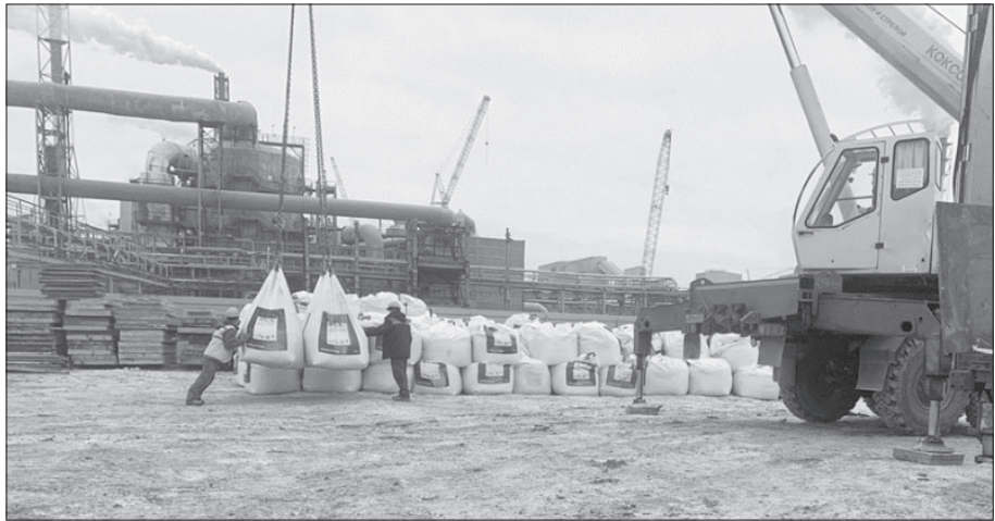
Рис. 4. Поставка готовой сухой смеси для жаростойкого бетона на строительную площадку
